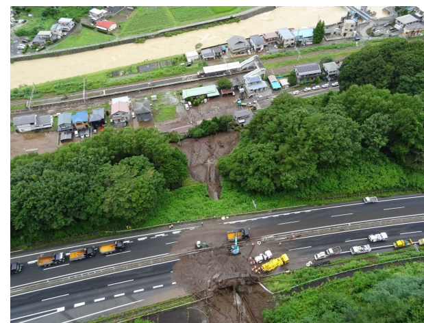
土石流による被害（長野県岡谷市）
