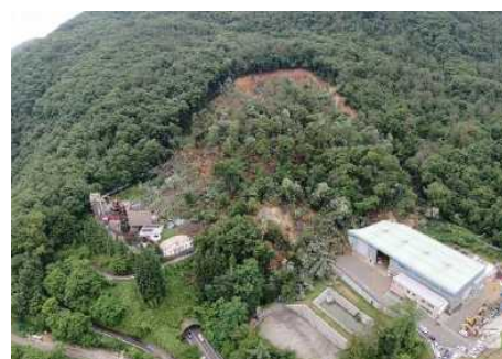
地すべりによる被害（長野県長野市）
