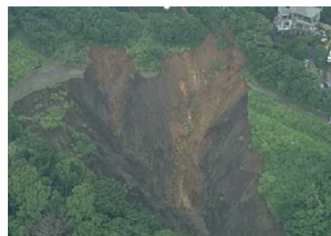
土石流による被害（静岡県熱海市）
