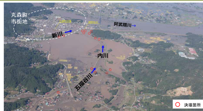
宮城県丸森町における浸水
