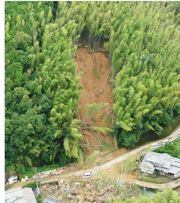
令和2年7月豪雨で発生したがけ崩れ(熊本県提供)
