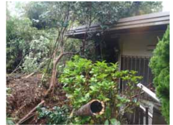
平成25年10月16日 5 台風第26号による土砂災害
