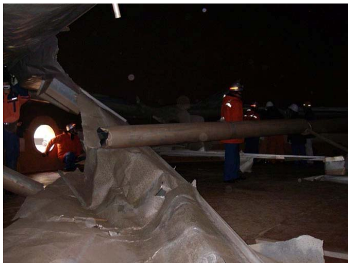
破断したデッキスキン、フロートチューブ
