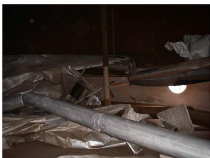
ゲージポール近傍の破損浮き蓋散乱状況
