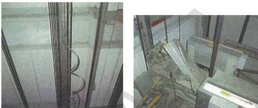
20 図6 エレベーターの主索周辺の損傷事故（主索切断）[写真左]と長尺
