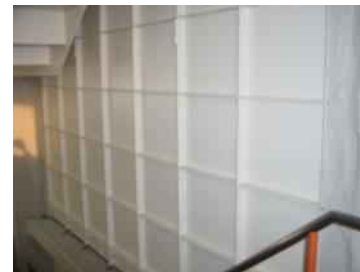
低降伏点鋼制振壁
