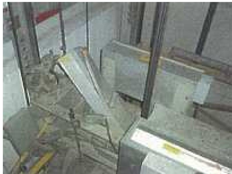
巻き上げ部主ロープ周辺の損傷事故（主ロープ切断・よれ・シープから外れ脱落）長尺物の接触により着床装置破損等
