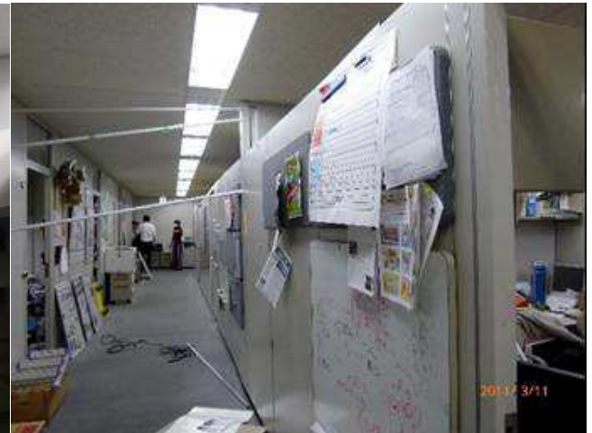
24F(本棚の転倒、間仕切り壁の大変形)
