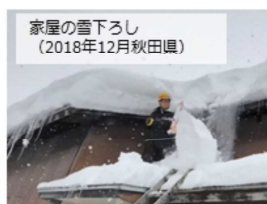
家屋の雪下ろし （2018年12月秋田県） 雪害、農業施設の倒壊
