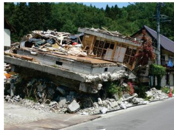
写真120 民家の倒壊 (一部撤去済) (第3.3.14図 -②)
