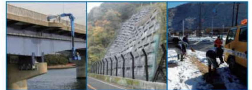
橋りょう点検
