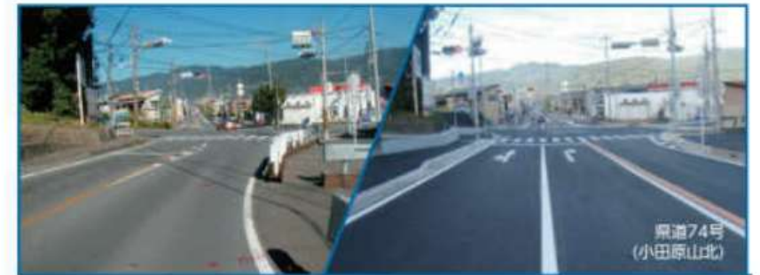
交差点の改良(施工前)
