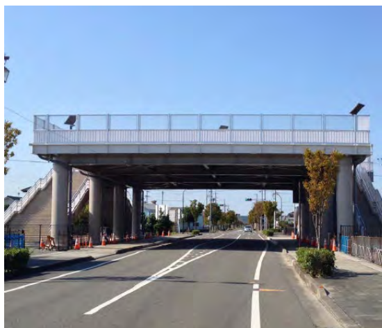
津波避難タワー(歩道橋型)
