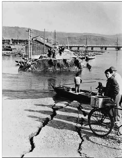
揺れによる堤防の決壊 高知市葛島堤防付近
