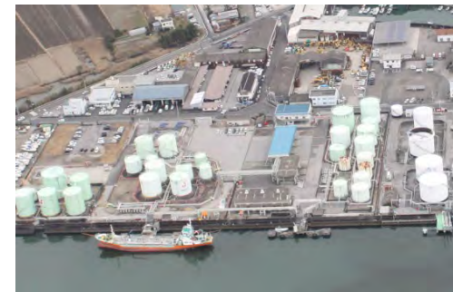
〔タナスカ地区石油・ガス基地〕
