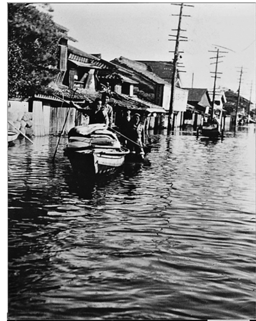
地盤沈下による浸水 高知市城見町付近
