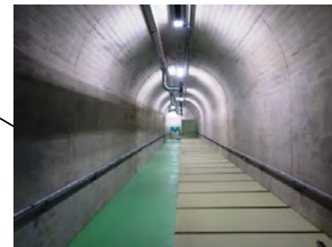
シェルター内部
