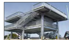
〔津波避難タワー〕
