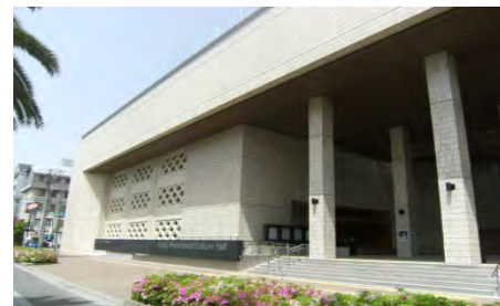
〔耐震化後（県民文化ホール）〕
