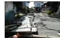
〔ブロック塀の倒壊〕
