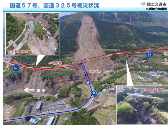
平成28年(2016年)熊本地震による阿蘇大橋付近の被害 九州地方整備局「阿蘇大橋地区復旧技術検討会(第1回)」資料から
