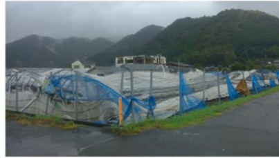
倒壊したビニールハウス 71
