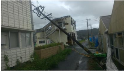
傾倒した電柱
