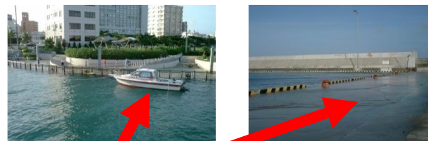
浸水被害写真
