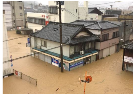
【大分県：津久見川水系津久見川(県管理)】 市街地の浸水被害
