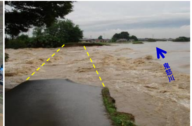
平成27年9月10日 12時50分 堤防決壊 決壊幅約200m
