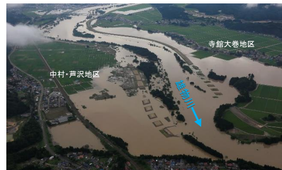
【秋田県:雄物川水系雄物川(国管理)】 中村・芦沢、寺館大巻地区の浸水被害
