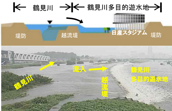
鶴見川の水位が上昇し、越流堤から鶴見川多目的遊水地に流入
