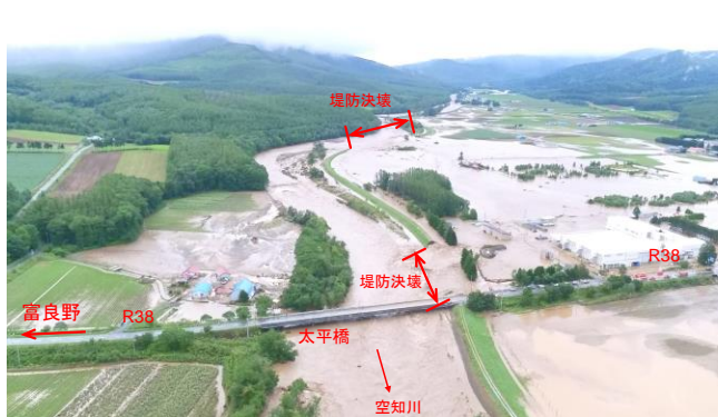
堤防決壊状況 全景(石狩川水系空知川)
