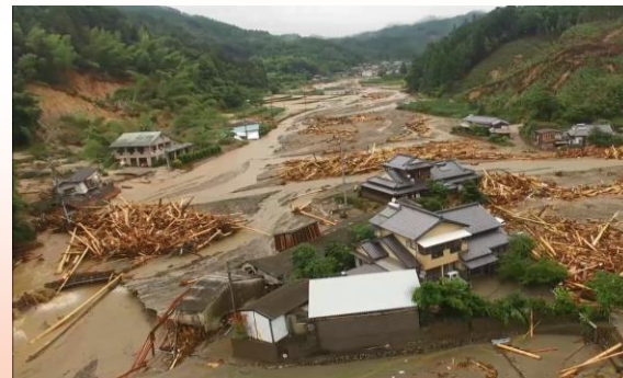
大量の土砂で埋没した赤谷川
