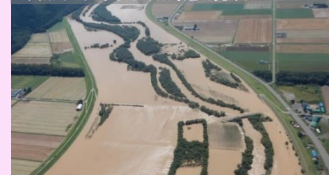
越水による堤防の法崩れ(常呂川)
