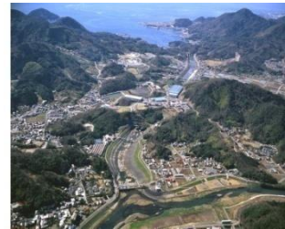
放水路(狩野川放水路)
