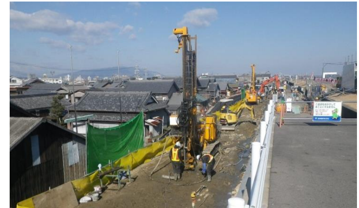
締固め工法による液状化対策(三重県桑名市)
