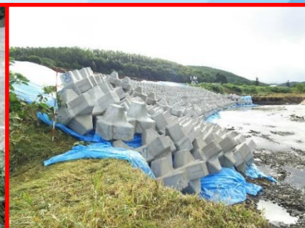
石狩川水系 美瑛川支川 辺別川KP7.2右岸の堤防の一部が流出 8月24日に緊急復旧工事に着手し、8月30日に完了
