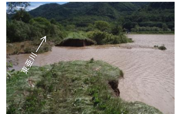
堤防の決壊(常呂川水系東亜川)
