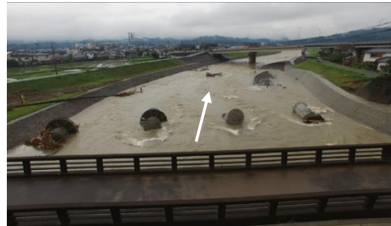
【大分県:筑後川水系花月川(国管理)】 JR久大本線の鉄道橋が流失
