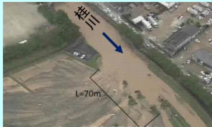
堤防決壊(桂川右岸) 福岡県朝倉市
