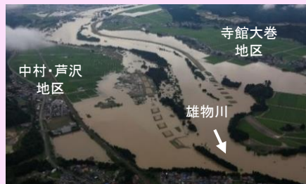
雄物川における出水の状況 秋田県大仙市
