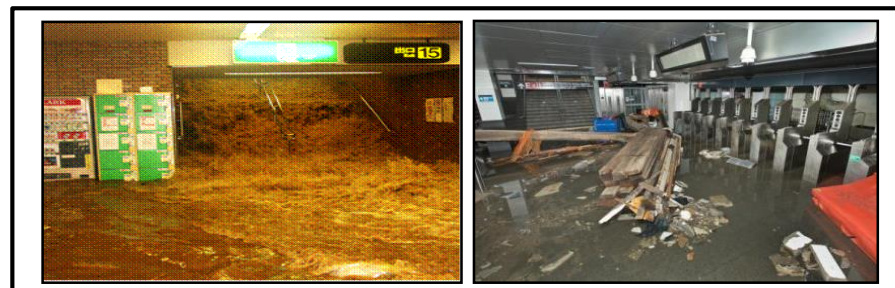
平成15年7月 梅雨前線による豪雨 福岡市営地下鉄博多駅
