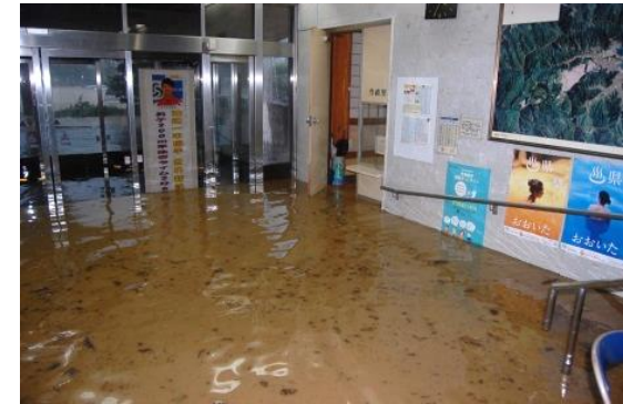
【大分県：津久見川水系津久見川(県管理)】 冠水した津久見市役所
