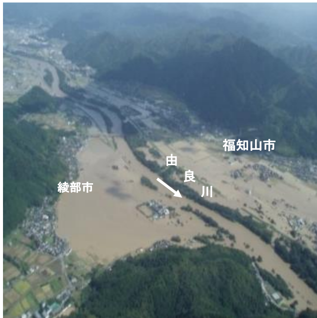
由良川(中流部)の被災状況(京都府福知山市、綾部市)
