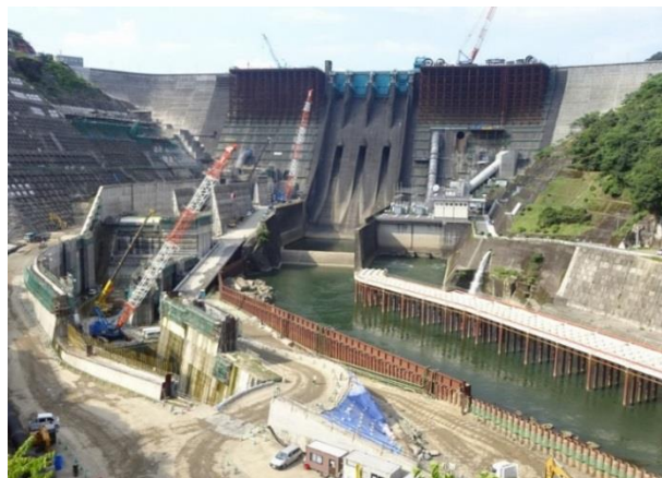
増設減勢工施工状況 (2015. 8)
