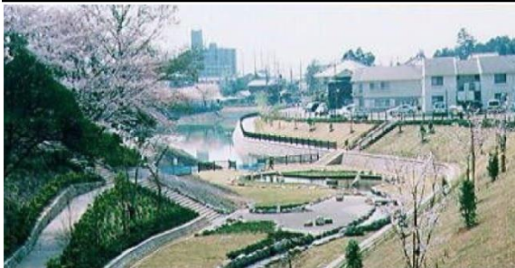
ため池の治水利用例 鰻堀池(大和郡山市)
