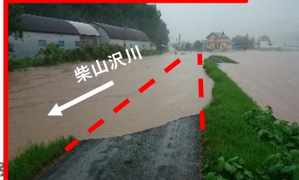
常呂川水系 柴山沢川の堤防が決壊 8月22日に緊急復旧工事に着手し、8月26日に完了
