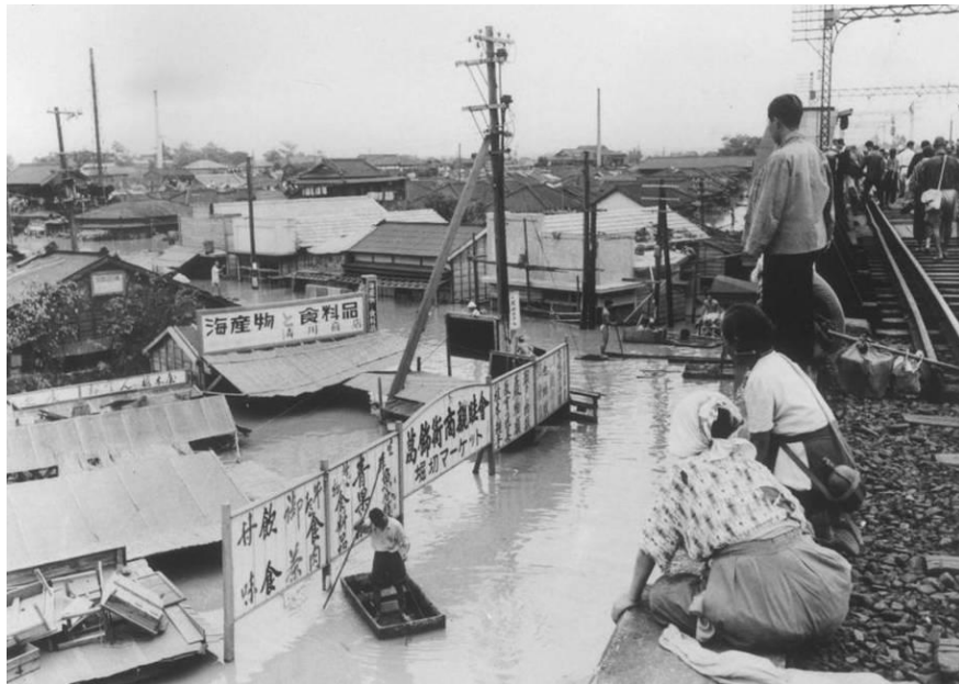
東京都葛飾区の浸水状況 (昭和22年の利根川及び荒川の氾濫による浸水)
