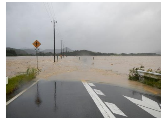
【京都府:由良川水系由良川(国管理)】 溢水による道路冠水
