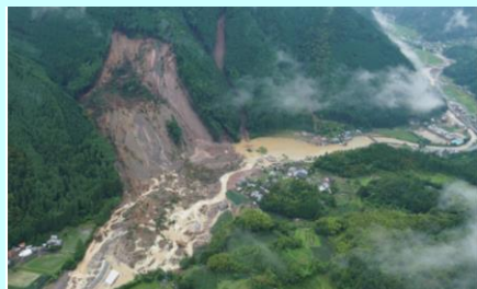
大規模な地すべりによる河道閉塞(小野川) 大分県日田市
