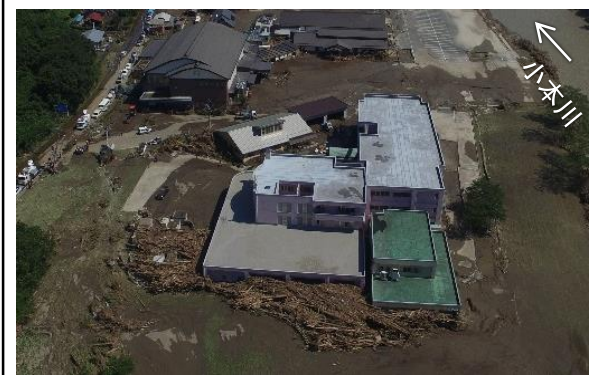
浸水被害状況(岩手県小本川)
