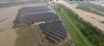
堤防の決壊による氾濫状況 (札幌川:北海道帯広市)
