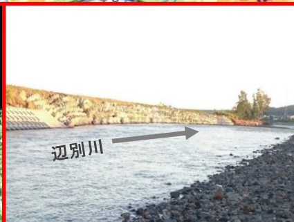
石狩川水系 美瑛川支川 辺別川KP6.0左岸の堤防の一部が流出 8月23日に緊急復旧工事に着手し、8月29日に完了
