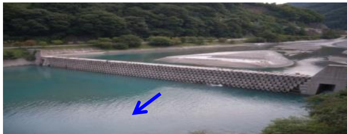
①貯砂ダム(粒径の大きい土砂を捕捉)
