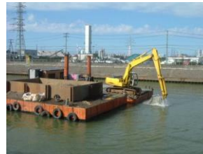
河床掘削 (関川水系保倉川)
