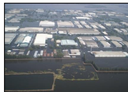
平成23年10月 タイ・チャオプラヤ川の氾濫によるロジアナ工業団地浸水状況
