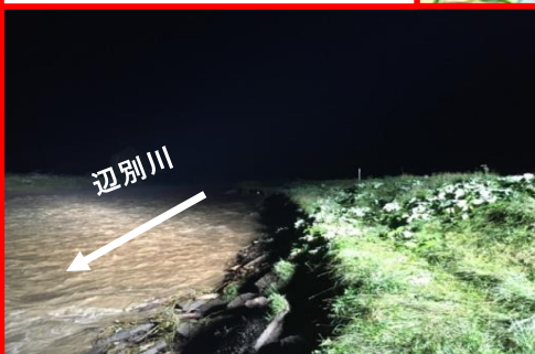
石狩川水系 美瑛川支川 辺別川KP6.0左岸の堤防の一部が流出 8月23日に緊急復旧工事に着手し、8月29日に完了
