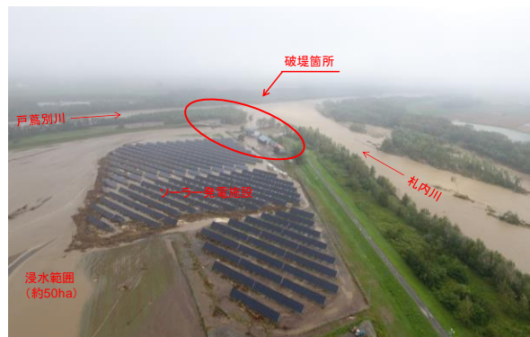
堤防決壊状況 全景(十勝川水系札内川)
