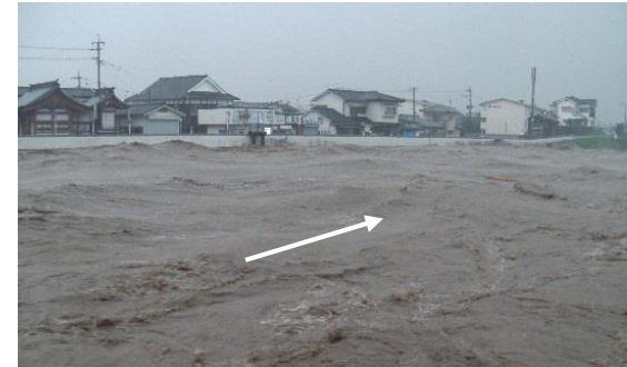
【大分県:筑後川水系花月川(国管理)】 洪水流下状況
