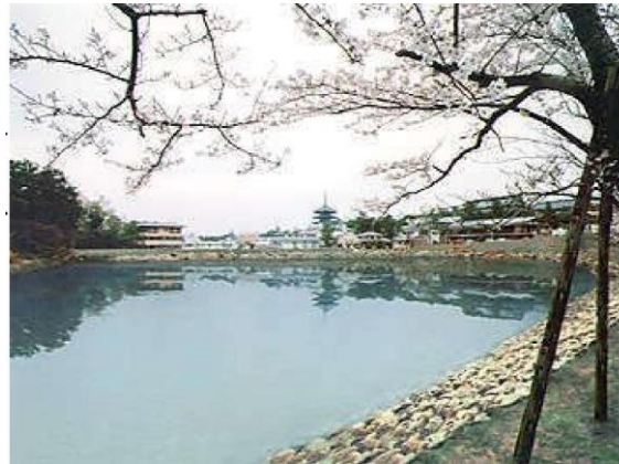
ため池の保全例 荒池(奈良市)
