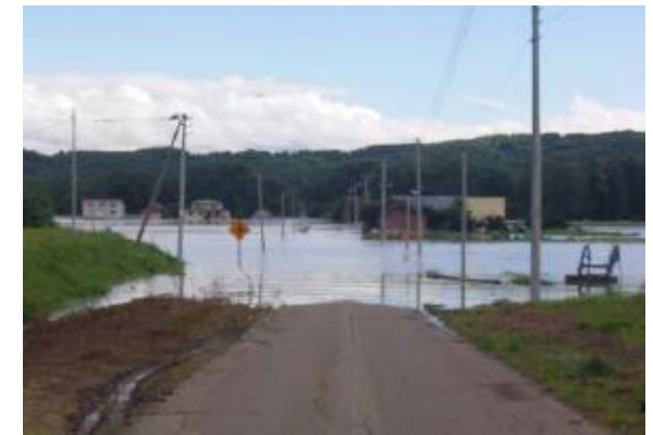
溢水による浸水被害(石狩川)
