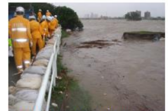
越水に対応するための積土の工
