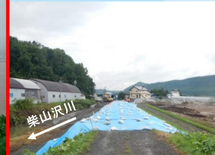
常呂川水系 柴山沢川の堤防が決壊 8月22日に緊急復旧工事に着手し、8月26日に完了
