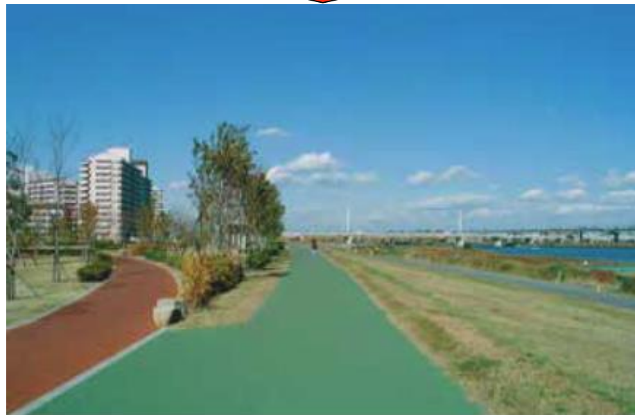
高規格堤防の整備によって市街地側は堤防とほぼ同じ高さに盛土
