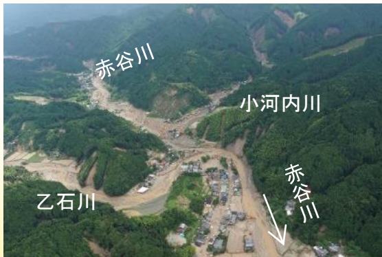
筑後川水系赤谷川における土砂・流木による埋塞状況
