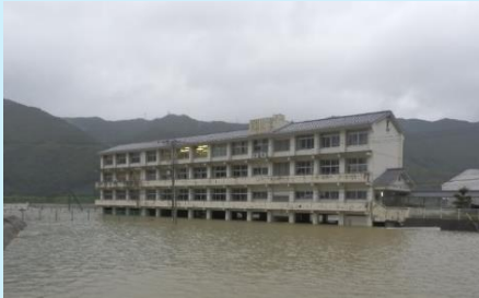
徳島県 阿南市 那賀川水系の浸水状況
