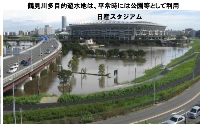
過去最大となる154万m 3 を貯留した鶴見川多目的遊水地
