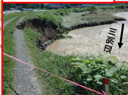
石狩川水系 美瑛川支川 辺別川KP7.2右岸の堤防の一部が流出 8月24日に緊急復旧工事に着手し、8月30日に完了
