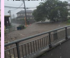
不老川の出水状況 (埼玉県狭山市)
