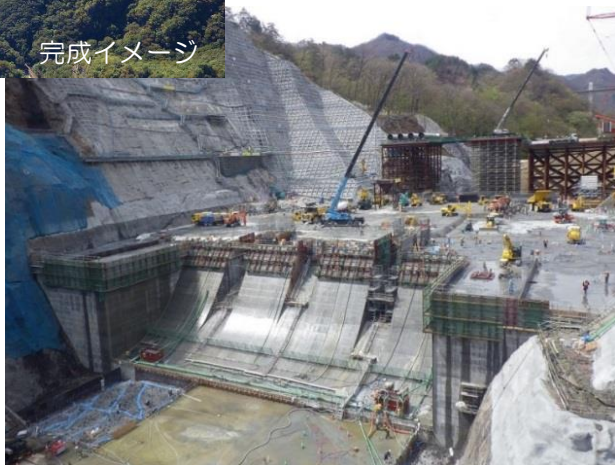
コンクリート打設状況 (H29.4)
