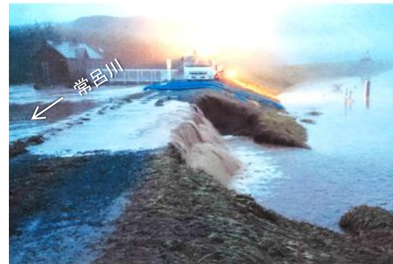
越水による堤防の法崩れ(常呂川)
