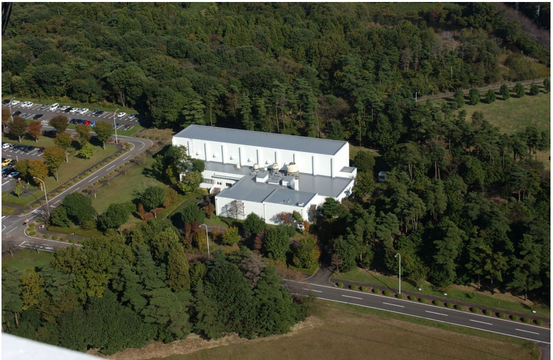
図 7-2-11 風洞建屋全景（平成20年）
