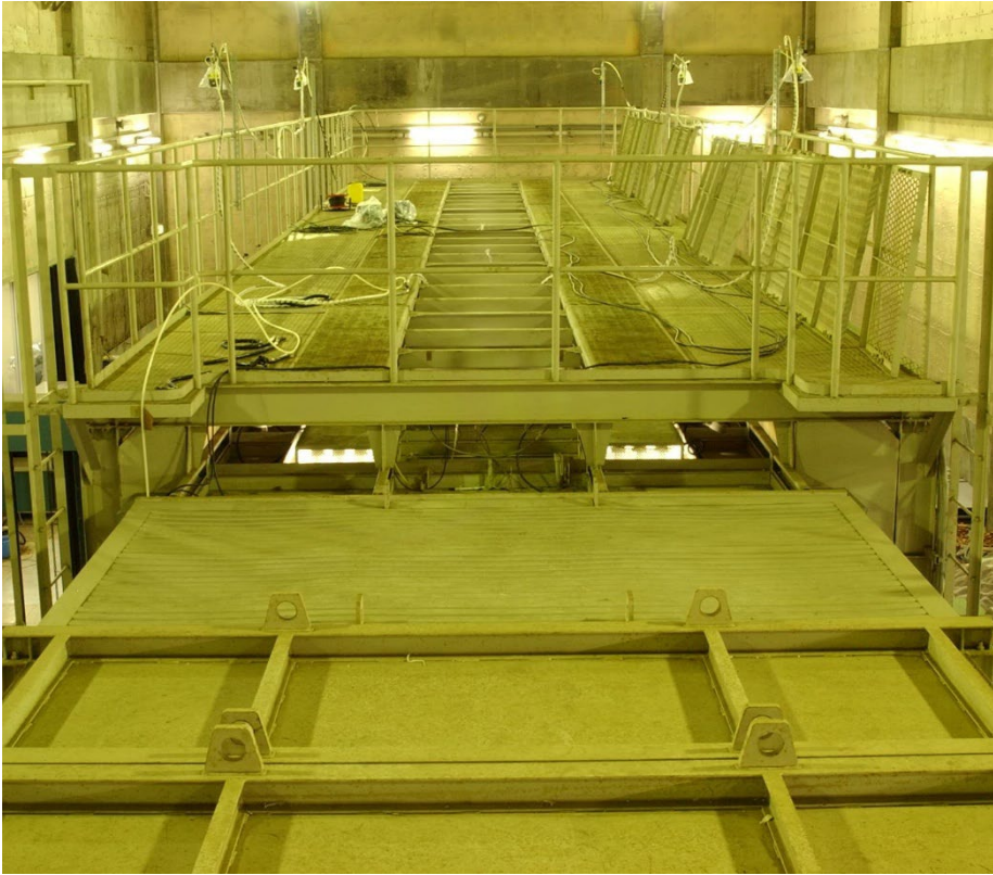
図 7-2-10 測定胴天井（平成19年）
