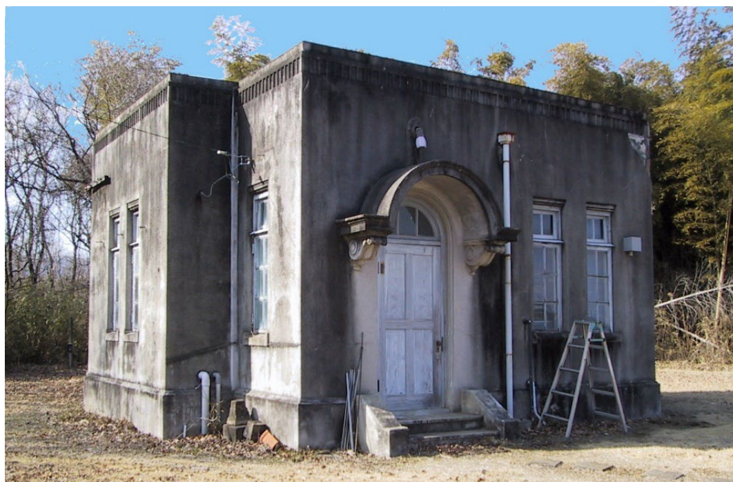
図 7-4-4 空中電気室（大正14年～）
