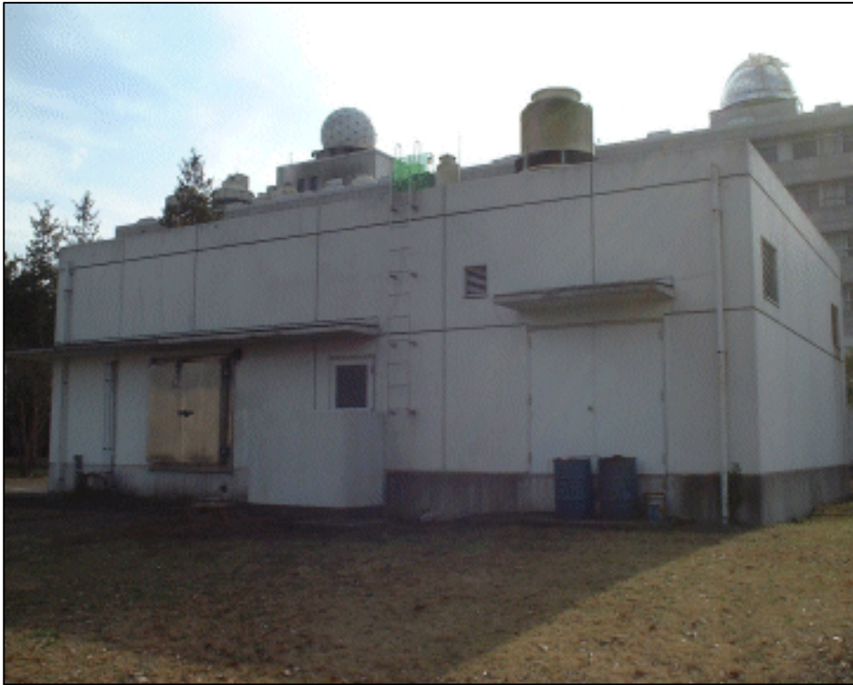
図 7-2-2 平成14年改修前の低温実験棟全景
