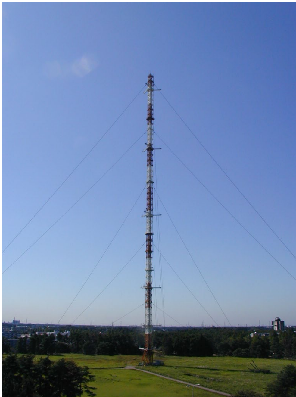
図 7-2-33 気象観測鉄塔（昭和50年～平成23年、観測期間昭和53年1月～平成21年1月） つくばの気象研究所の露場に整備され、高度10m、25m、50m、100m、150m、200m、213mで風向・風速、気温、湿度の常時観測を行っていた。静電容量式の湿度計が気象庁では初めて導入された。境界層の観測を行うとともに、航空機観測やウィンドプロファイラー、ライダーなどとの同時観測、精度検証などにも貢献した。データは学术论文に公表されるとともに気象庁をはじめ他の研究機関に提供された。
