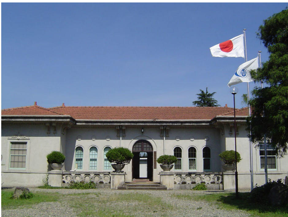
図 7-4-2 本館（第一庁舎）（大正14年～）
