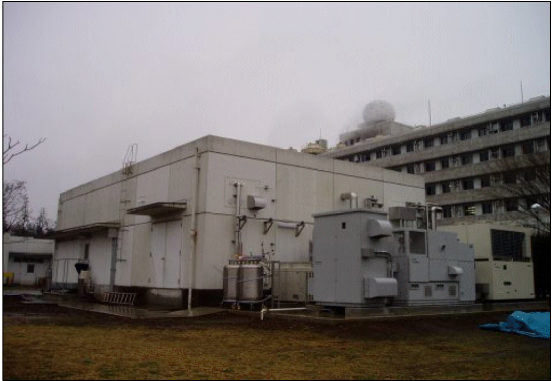
図 7-2-4 平成16年改修後の低温実験棟全景
