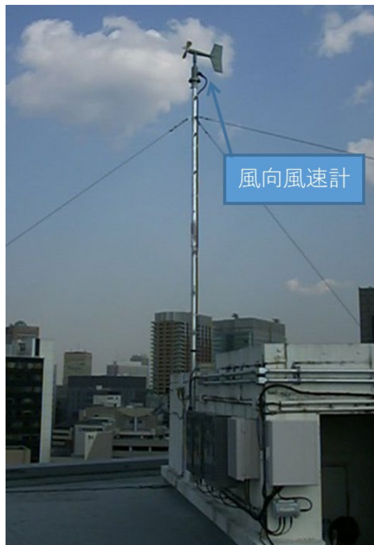
図 5-5-9 大阪市東中本地域の学校屋上に 設置した風向風速計
