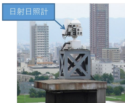
図 5-5-6 大阪合同庁舎第2号館及び 第4号館それぞれの屋上に 設置した日射日照計
