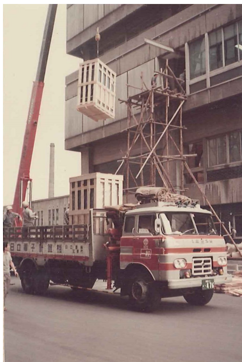
図 4-1-21 搬入作業の様子
