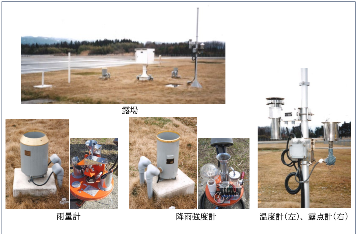
図 3-2-2 空港気象常時監視通報装置、空港気象常時監視装置（1/3）
