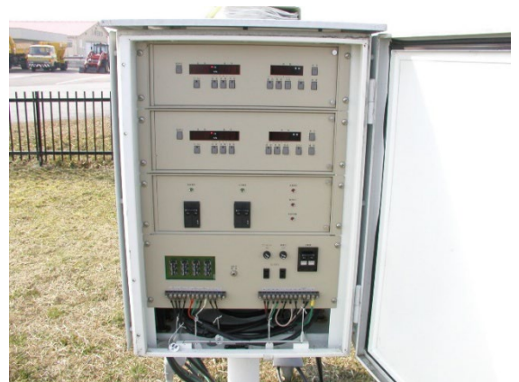
風向風速計（屋外変換部）
