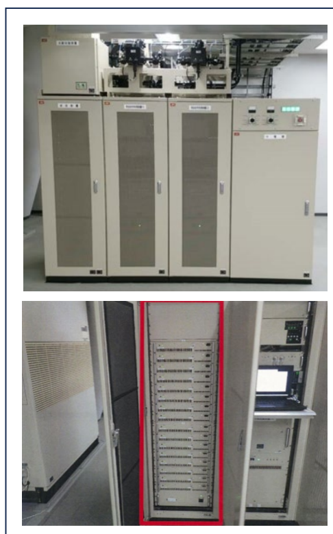
図 3-2-25 送信装置（固体素子）
