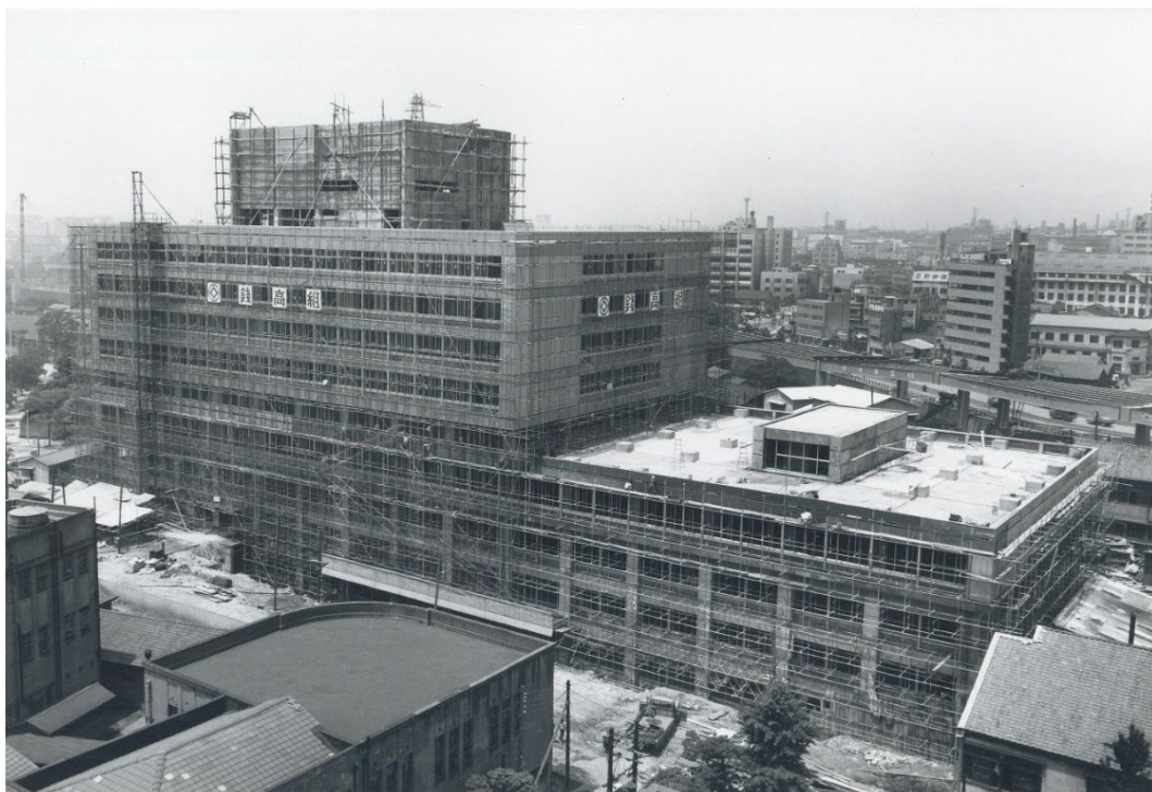
図 1-2-5 庁舎南側（建設中） （写真提供：株式会社銭高組）
