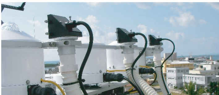
第 3.5 図 防塩装置 (左: 通常時 右: 洗浄動作中)
