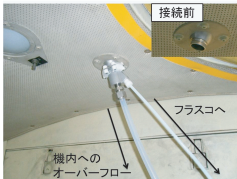
写真 4.2 外気吹き出し口との接続部
