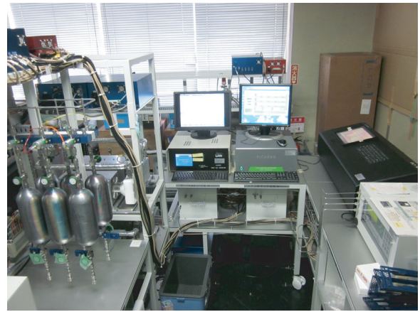
写真 4.6 航空機採取型温室効果ガス観測装置(分析部) (気象庁本庁地下1階に設置)
