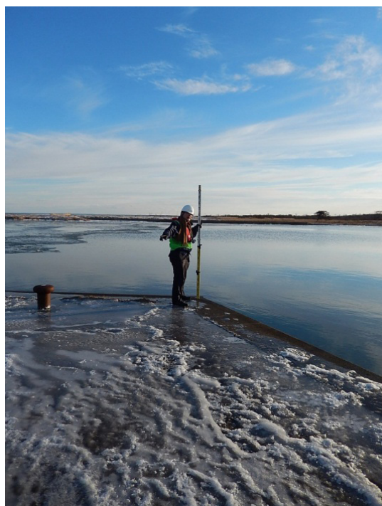
第 9 図 海面の高さを利用した水準測量
