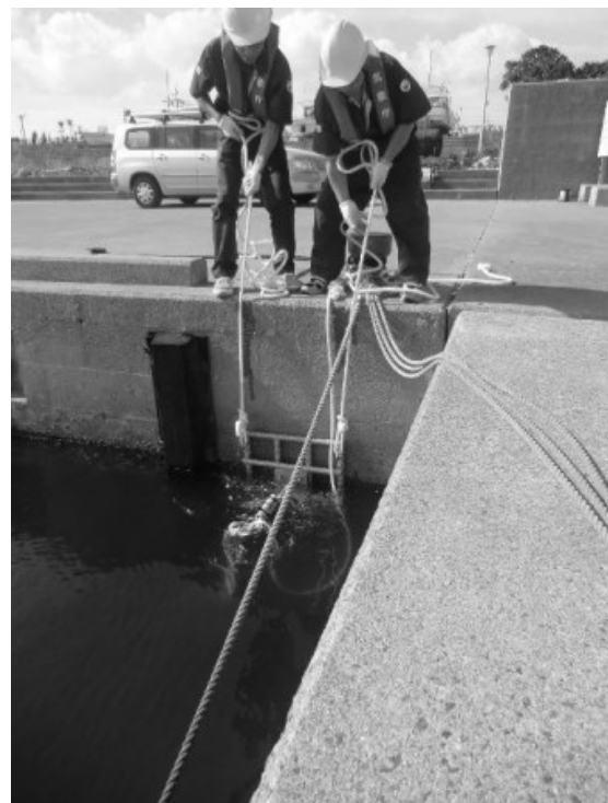
第2図 簡易水位計の設置作業
