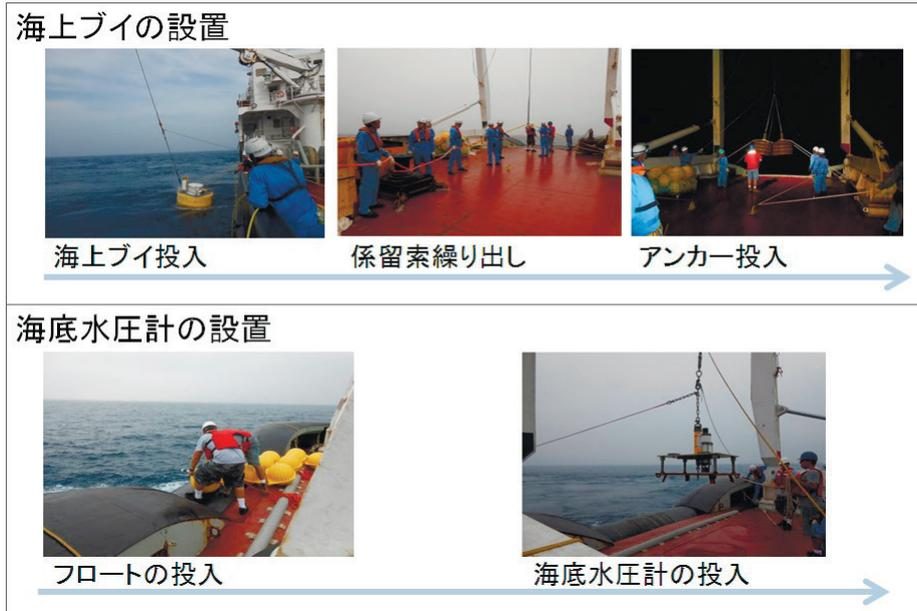
第10図 海上ブイ及び海底水圧計の設置作業の様子
