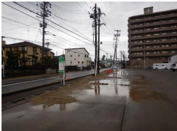
写真3-46 駐車場の泥水噴出 (新潟市西区青山一丁目)
