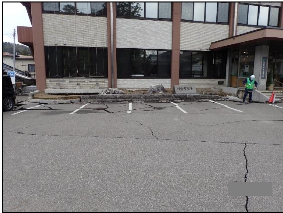
写真3-1 路面の亀裂
