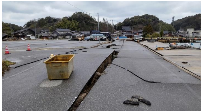
写真3-105 岸壁の損壊
