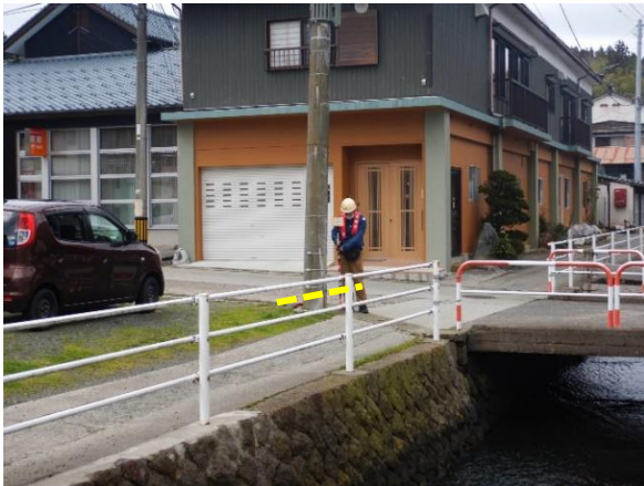
写真3-126 津波の痕跡 (図3-41 ⑥-1)
