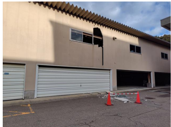
写真3-21 外壁の破損
