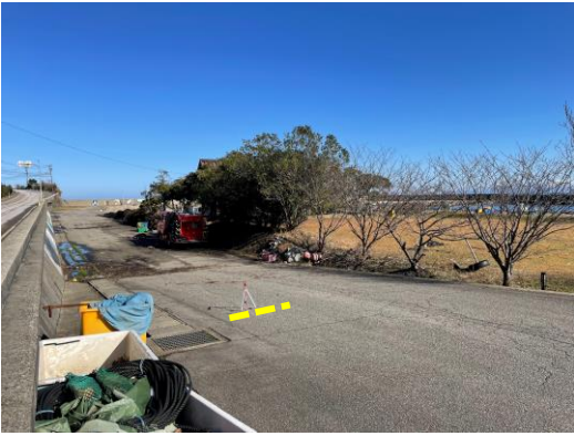
写真3-106 津波の痕跡 (図3-26 ①-1)
