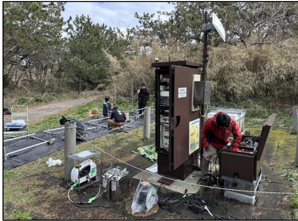
写真7-1 発動発電機からソーラー給電への変更作業（輪島市舳倉島観測点）
