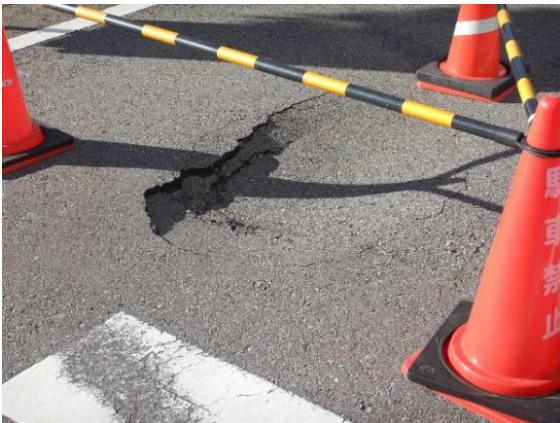
写真3-45 路面の陥没
