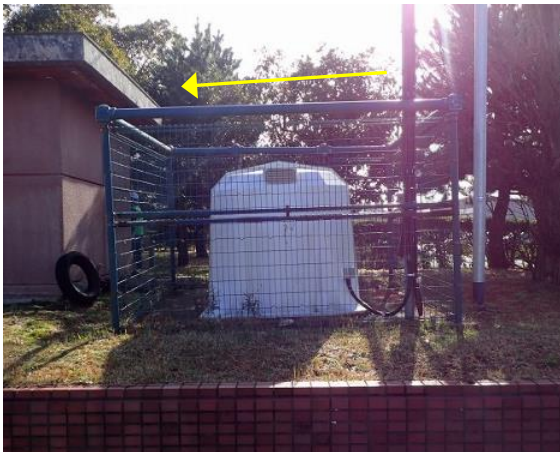
写真3-24 地盤の変形 左下方に傾いている
