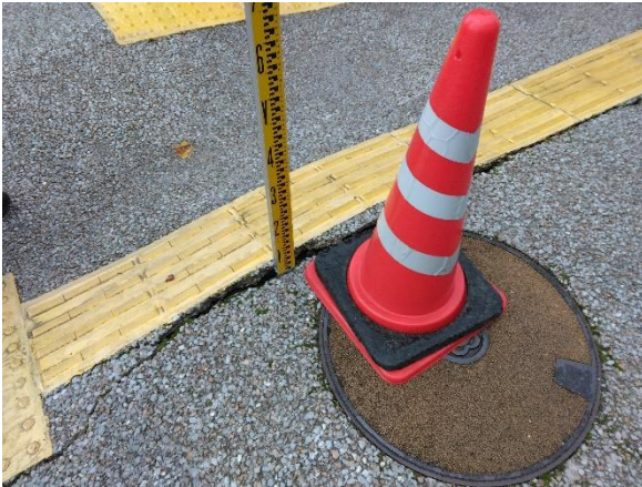
写真3-16 路面の亀裂
