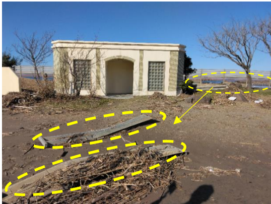
写真3-121 津波により流出した防砂柵
