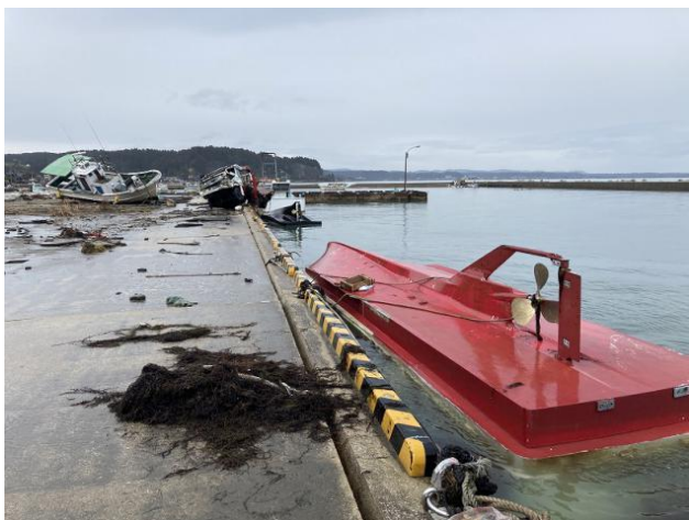
写真3-83 転覆や岸壁に打ち上げられた船 (珠洲市鵜飼漁港)
