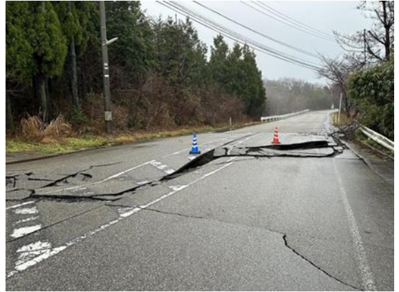
写真3-3 路面の損壊
