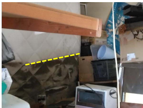
写真3-123 津波の痕跡 (図3-40 ⑤-2)
