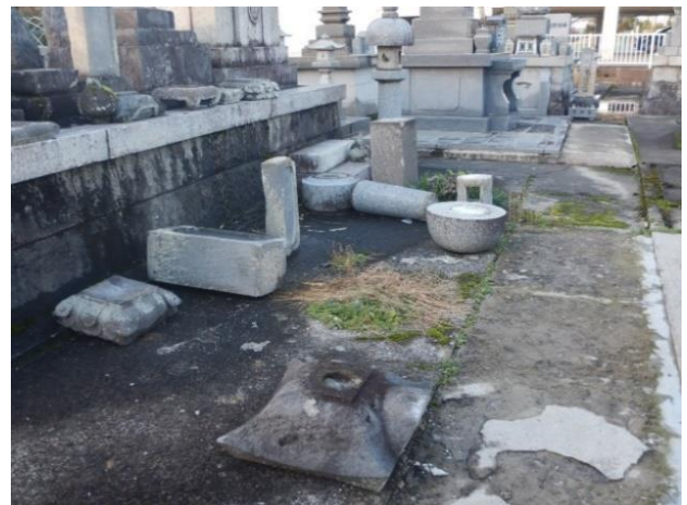
写真3-70 墓石の転倒・倒壊
