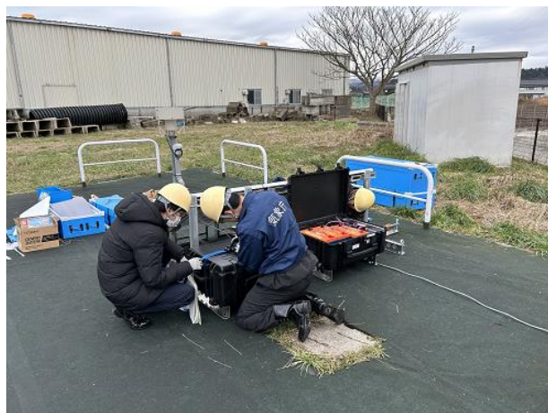
写真7-4 可搬型電源装置によるバッテリーの増設作業（珠洲観測所）
