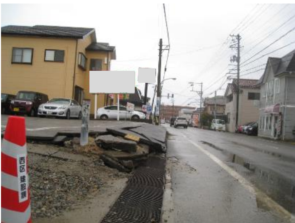
写真3-39 液状化による地盤隆起
