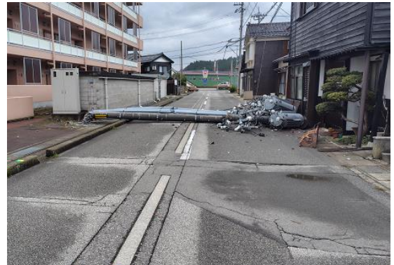
写真3-5 電柱の倒壊
