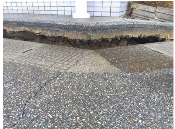
写真3-10 路面の陥没
