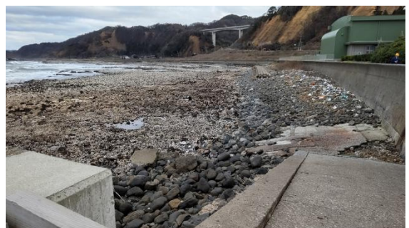
写真3-8 地盤の隆起による海底の露出
