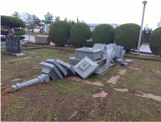
写真3-9 石灯籠の倒壊
