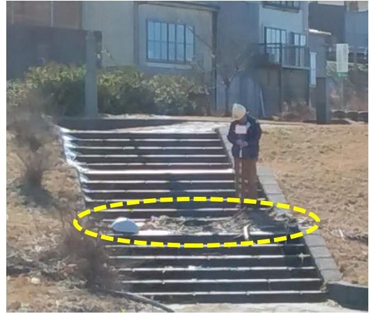
写真3-120 津波の痕跡 (図3-39 ④)
