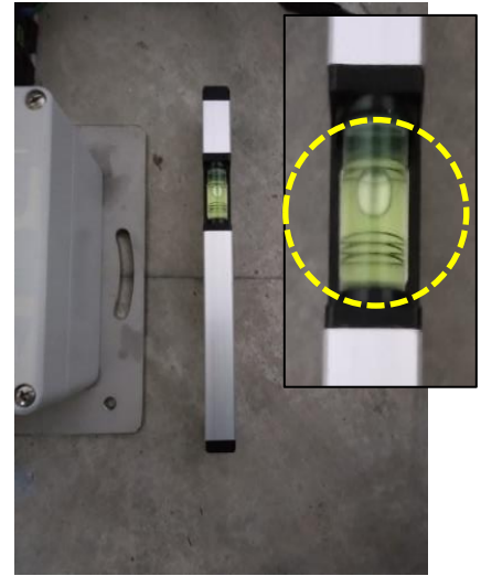
写真3-23 震度計台の傾き 点線内気泡が標線内からずれている
