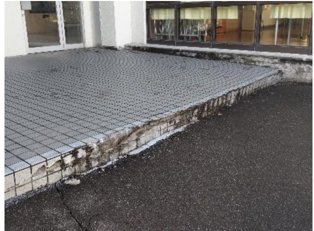
写真3-35 路面の沈下
