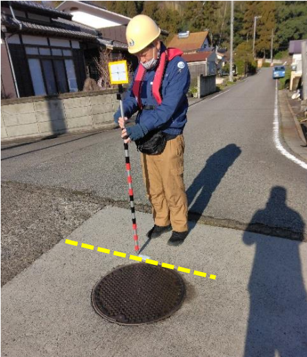
写真3-129 津波の痕跡 (図3-42 ⑦-3)
