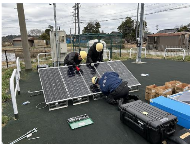
写真7-2 可搬型電源装置太陽光発電パネル設置作業（珠洲観測所）
