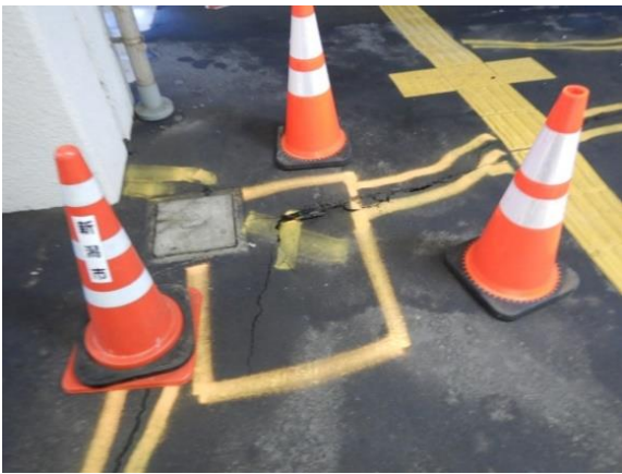
写真3-37 路面の亀裂
