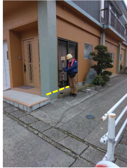
写真3-125 津波の痕跡 (図3-41 ⑥-2)
