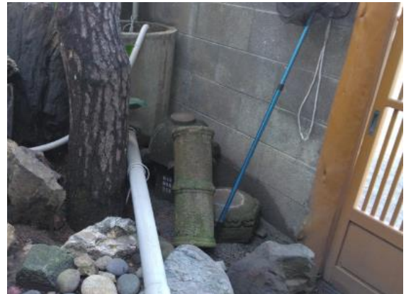
写真3-44 石灯籠の倒壊と格子戸の歪み
