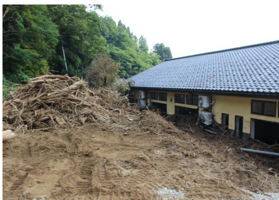
新潟県関川村の土砂災害 (8/11 撮影 気象台職員撮影)
