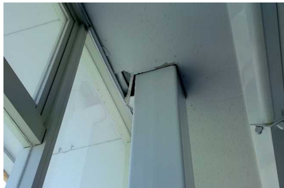
写真3-25 天井の破損
