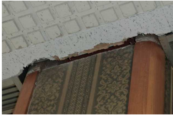
写真3-33 天井の破損
