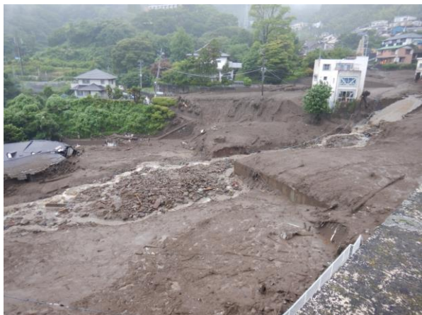
静岡県熱海市の土砂災害 (7/4撮影 気象台職員撮影)
