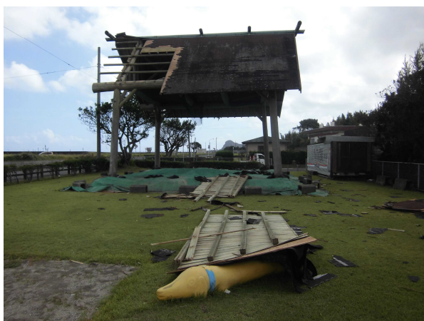
鹿児島県枕崎市の暴風による被害 (9/7撮影 鹿児島県枕崎市提供)
