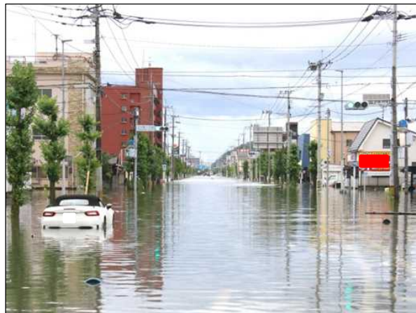
福岡県大牟田市の浸水害 (7/7撮影 大牟田市提供)
