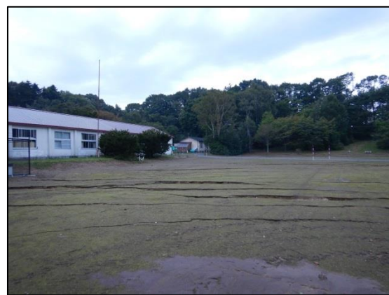
写真 2 地面の地割れ (厚真町鹿沼)
