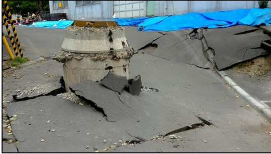
写真 59 地盤沈下 (札幌市清田区里塚)
