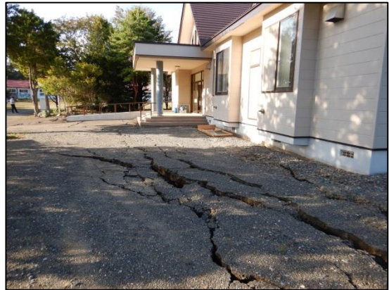
写真8 建物前の地割れ (厚真町鹿沼)
