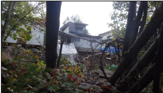
写真 64 住居裏の滑落・崩壊 (北広島市大曲並木) (北広島市提供)
