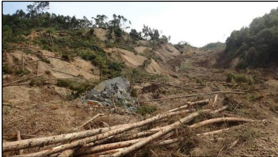
写真 30 幌内川崩落 (厚真町日高) (北海道開発局提供)
