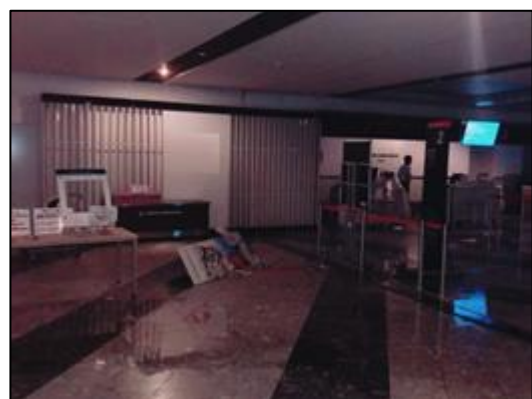
写真 42 立て看板の転倒
