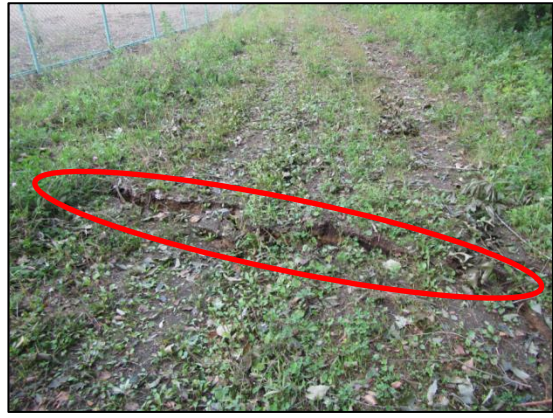
写真22 地盤の段差 (安平町追分柏が丘)
