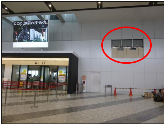
写真 45 壁板の落下
