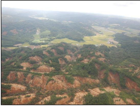
写真 28 斜面崩壊 (厚真町高丘) (北海道開発局提供)
