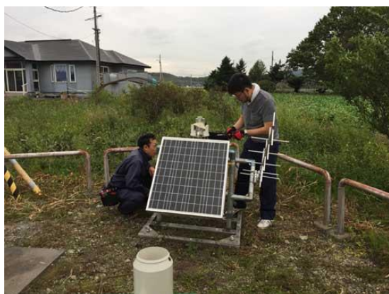
可搬型 DCP 雨量観測装置設置作業 (厚真地域気象観測所)
