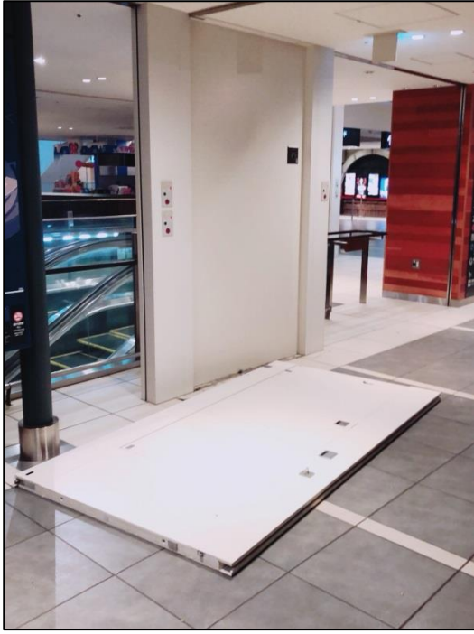
写真 47 パネルドアの転倒
