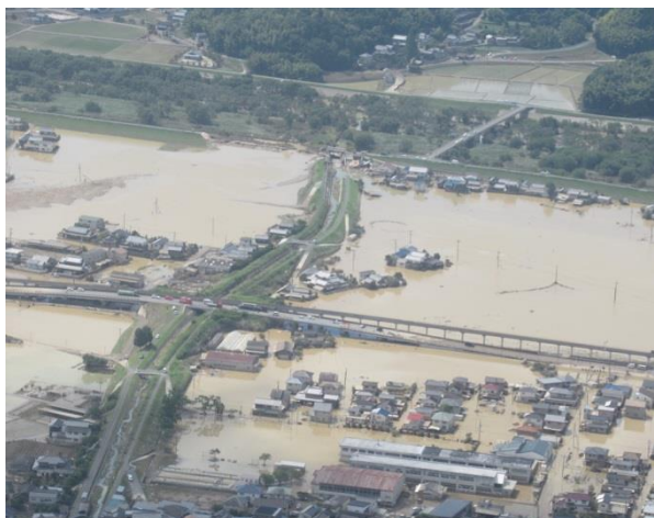
岡山県倉敷市真備町上空から見た浸水状況 (7/9 撮影 気象台職員)
