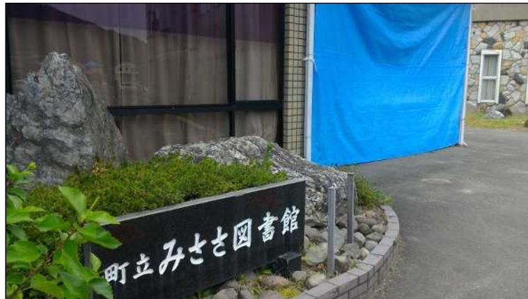
写真 9 図書館の窓ガラス割れ（ブルーシート部分） （三朝町大瀬）
