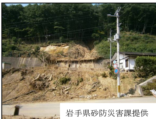
がけ崩れ 8/14 盛岡市繫字湯ノ館
