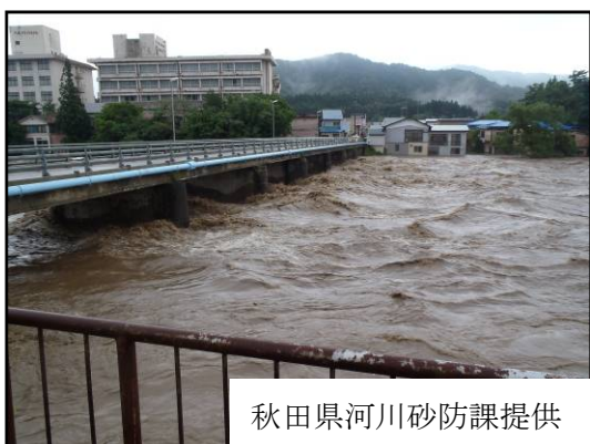
河川はん濫 8/9 米代川（大館市十二所）
