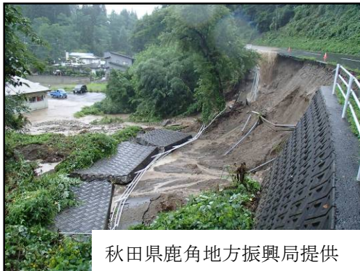
擁壁決壊 8/9 県道十二所花輪大湯線 （新山地区）
