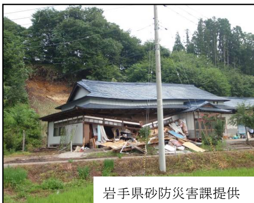
がけ崩れ 8/11 雫石町西安庭
