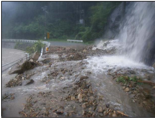
⑤ 土砂崩れ: 県道 50 号田所国府線 (浜田市)
