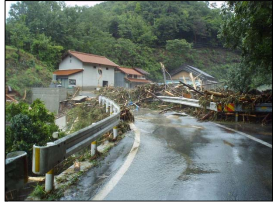
② 溪流からの土砂流入: 県道 297 号皆井田江津線 (江津市)
