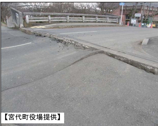
写真 29 亀裂南埼玉郡宮代町百間 橋梁接続部の道路陥没及び亀裂
