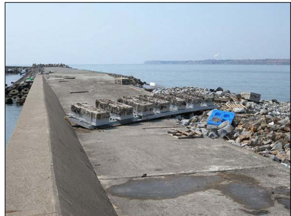
写真 13 岸壁に打ち上げられた筏
