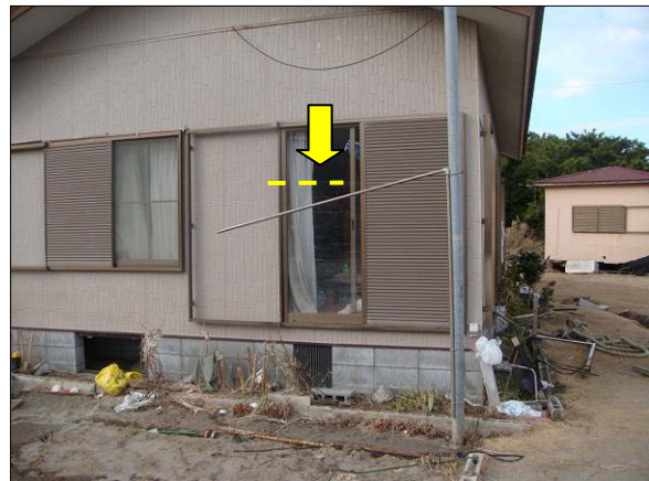
写真 1 津波の痕跡（図 11 の 53）
