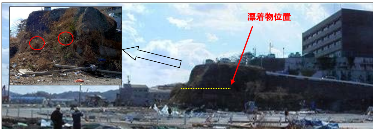
写真 6 津波の痕跡（宮古港付近の急傾斜地に漂着物が確認された、図 6 の 25）
