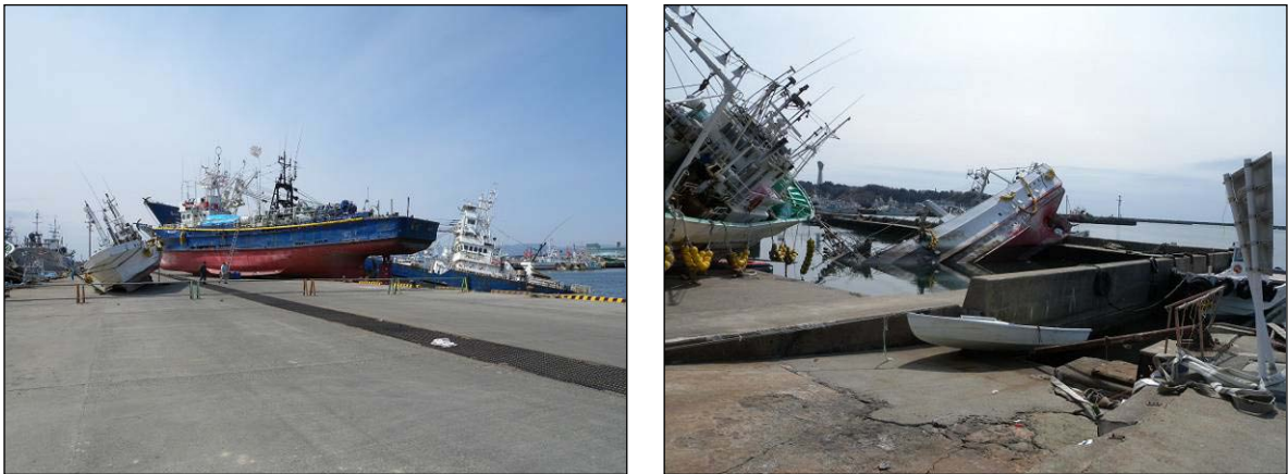
写真 48 小名浜漁港の被害状況
