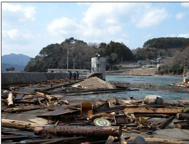
写真 25 防波堤内側の被害状況
