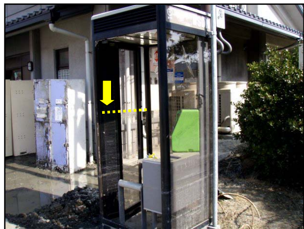
写真 38 津波の痕跡（図 22 の 40）
