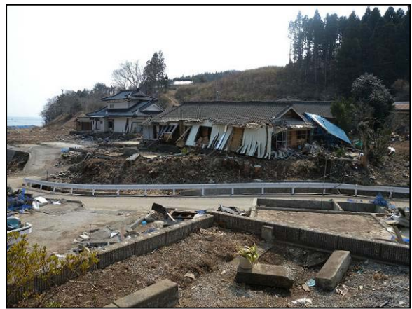
写真 17 津波により破壊された家屋
