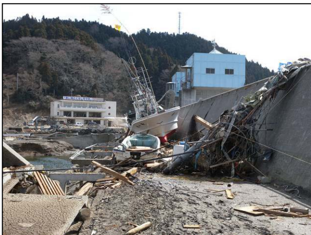
写真 22 防波堤内側の被害状況
