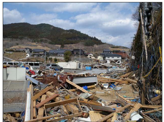
写真 26 岸壁から見た長崎地区の被害状況
