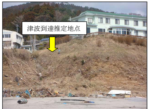
写真 18 津波の痕跡（図 11 の 31）
