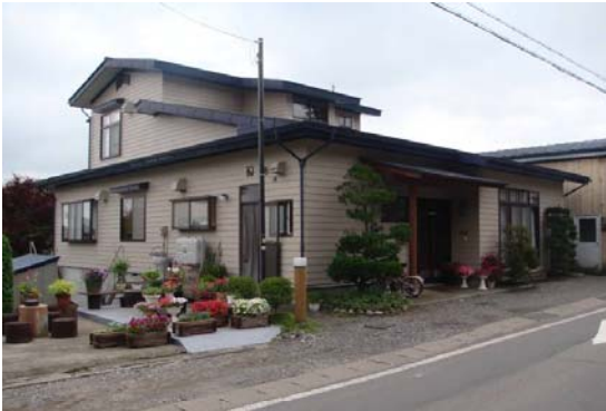
震度観測点の南東側約100mの民家。2階本棚から3分の1位の本が落ちた。換気扇は外れ、タンスは数cmずれ、引出しが2〜3cm飛び出た。2階の窓が自然に開いた。(築23年)
