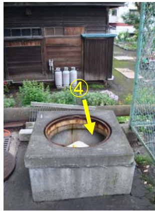
② 南西方向から見る 岩手県大野震度 計 震度計敷地 より 160cm の段差の 下に民家。
