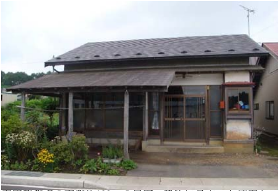
震度観測点の南側約100mの民家。建物に目立った被害なし。
