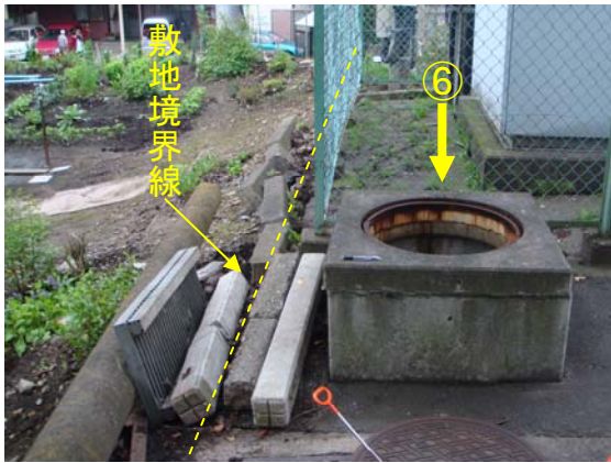
① 北西方向から見る岩手県大野震度計。 (矢印の場所) 距離 150cm に変電設備がある。40cm と離れないところに高さ 160cm の段差 がある。庁舎の敷地を囲ったブロックが 崩れている。
