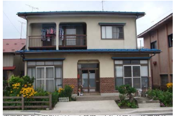
震度観測点の南側約100mの民家。小物が落ち、冷蔵庫が数cmずれた。建物に目立った被害なし。(築22年)
