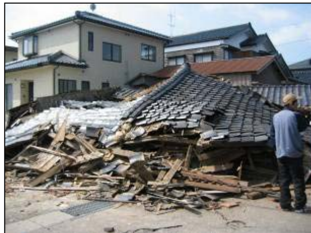
写真 ( 2 ) 全壊した家屋と外見上被害が見られない家屋
