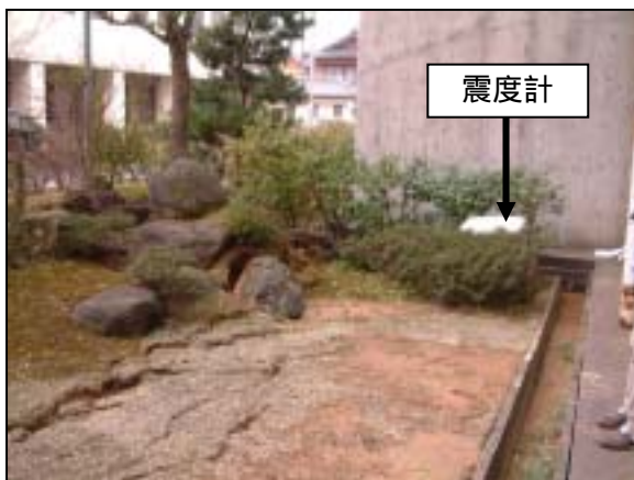
写真 震度計周辺環境 震度計周辺が液状化により地盤の隆起
