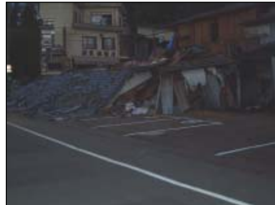
写真 2-11 全壊した住居
