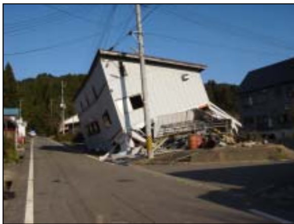
写真 2-16 1階部分が潰れ倒壊した家屋
