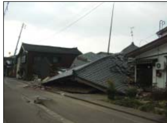
写真 2-27 倒壊した家屋 （図 2-2-5 の No. 4）
