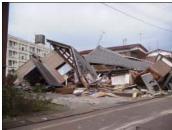
写真 2-28 倒壊した 2 棟の家屋 (図 2-2-5 の No. 5)
