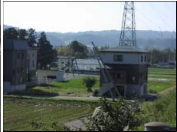
写真 2-2 傾いた電柱（小千谷 IC 付近）
