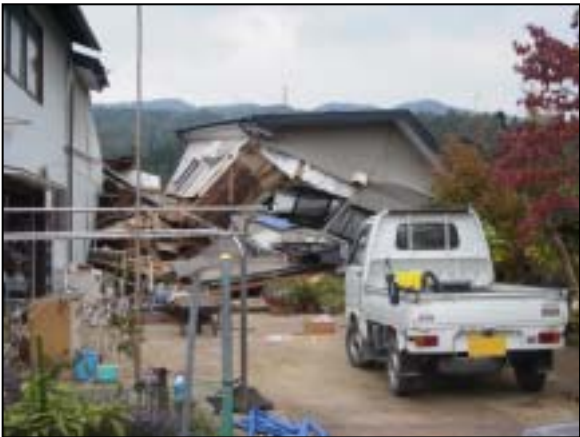
写真 2-22 倒壊した家屋
