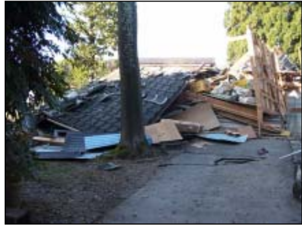
写真 2-15 全壊した家屋
