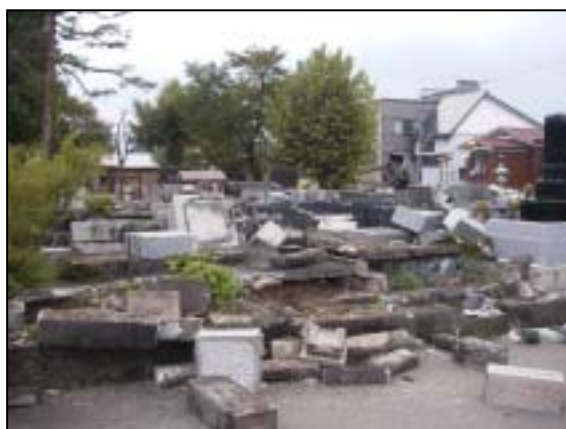
写真 2-30 倒壊した石碑と墓石 (図 2-2-5 の No. 7) 9 割程度の墓石が倒壊している。
