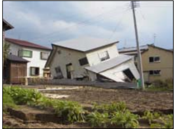
写真 2-23 倒壊した家屋
