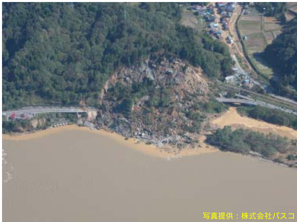
写真 4 - 2 崖崩れ（小千谷市・長岡市境付近、写真提供：株式会社パスコ）
