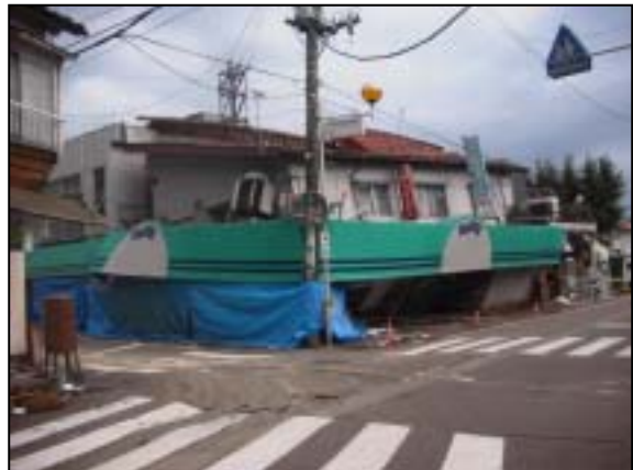
写真 2-25 1階部分の店舗が潰れた家屋 （図 2-2-5 の No. 2）
