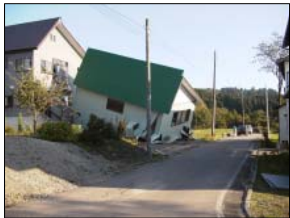
写真 2-17 基礎部分が潰れ倒壊した家屋
