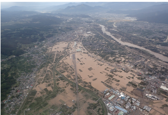
千曲川堤防決壊による浸水状況（長野県長野市） （写真：北陸地方整備局提供）
