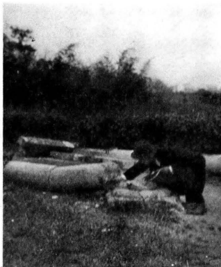
(16) 生駒郡矢田村新村の石鳥居 (柱の徑30cm, 高さ3.5m) 基 石上5cm位の所より西側へ倒る。
