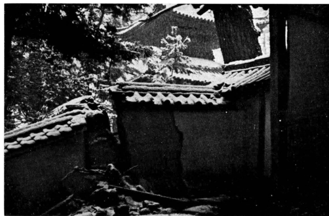
(12) 太子堂の土塀の破壊
