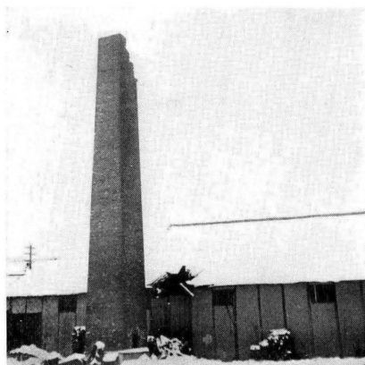
(8) 奈良縣高田町煙草工場の煙突折損。
