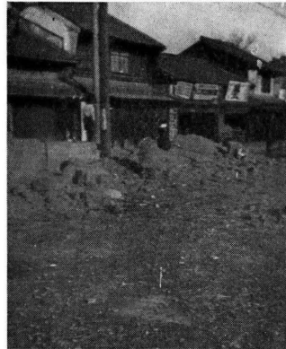
(2) 高田町の土塀 (高さ約 2m, 長さ10m, 厚さ40 cm) 東へ倒壊。
