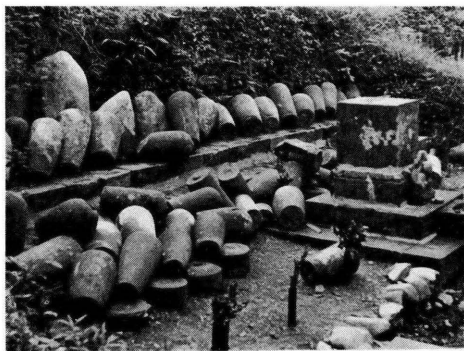
(20)西大谷，大谷川南岸の墓石轉倒(北方へ倒る) (21)東大谷，土藏の破損 (22)西大谷，大正寺内墓石轉倒(東徼北方へ倒る) (23)西大谷，地震後火災に罹りし家屋の慘狀
