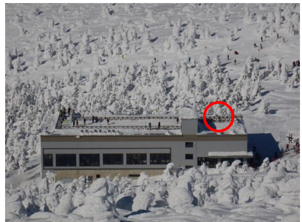
図 2：蔵王ロープウェイ地蔵山頂駅の冬季の状況。赤丸が実験装置設置場所。駅周辺の木々は、樹氷化していることがわかる（2016/02/12 地蔵岳から撮影）。
